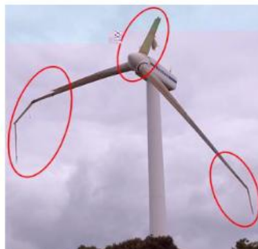
8号風車:ブレード3枚破損
