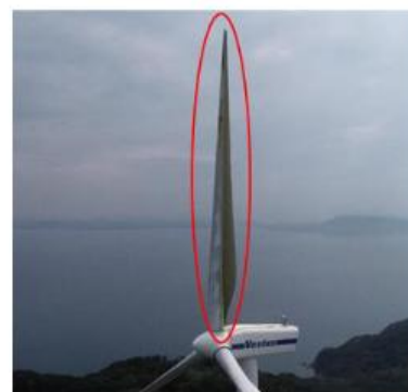
7号風車:ブレード1枚破損
