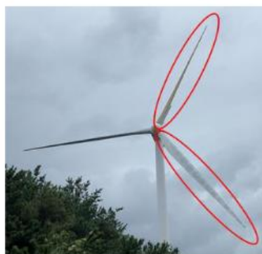
16号風車:ブレード2枚破損
