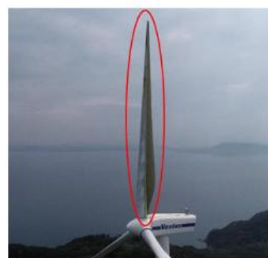
7号風車:ブレード1枚破損
