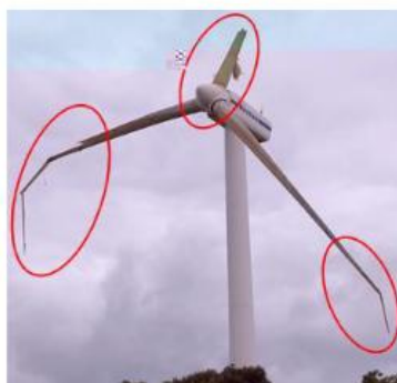
8号風車:ブレード3枚破損
