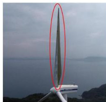
7号風車:ブレード1枚破損
