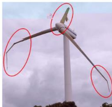
8号風車:ブレード3枚破損
