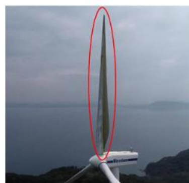
7号風車:ブレード1枚破損
