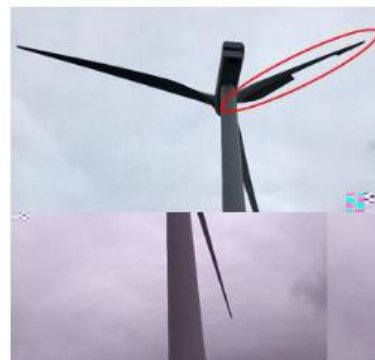
13号風車:ブレード1枚破損
