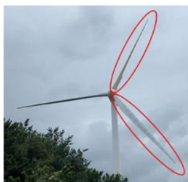
16号風車:ブレード2枚破損
